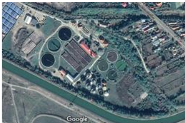
Fig. 4.47. Stația de epurare apă uzată Piatra Neamț
