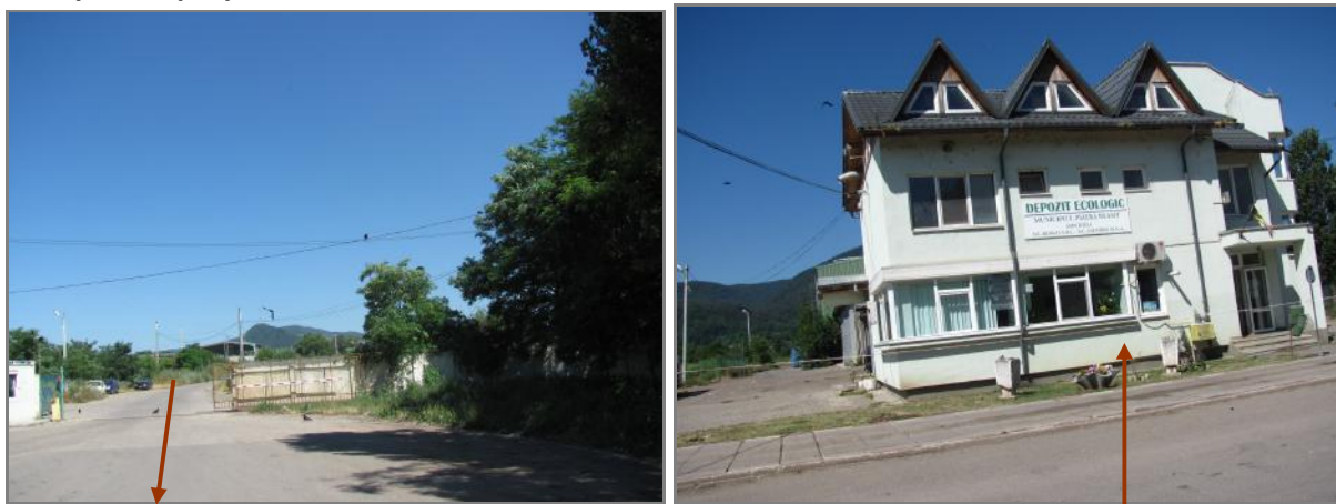
Intrare și clădirea de la intrarea în incinta Depozitului ecologic
