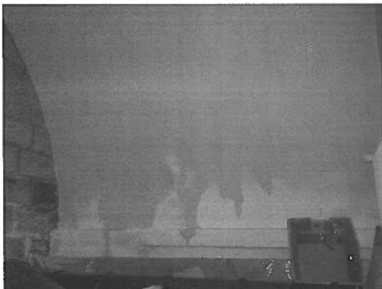
FOTO ZONA INTRARE – infiltratii la „nasterea” boltii – detaliu
