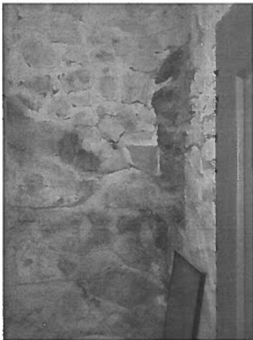
FOTO ZONA SAS GRUP SANITAR – degradarea generata de infiltratii ale apelor meteorice din cauza vandalizarii luminatoarelor si a neventilarii spatiilor
