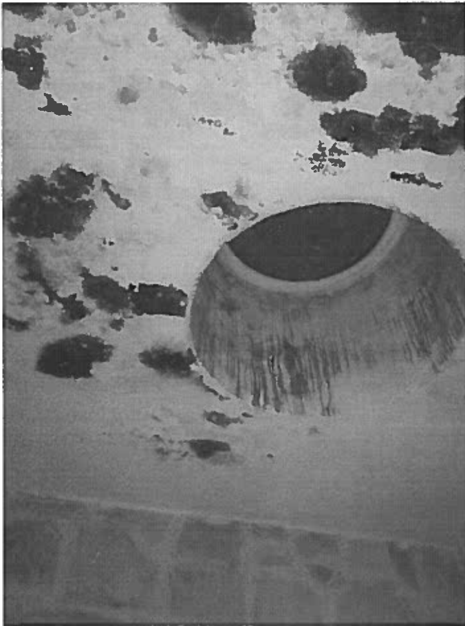
FOTO ZONA SAS GRUP SANITAR – degradarea generata de infiltratii ale apelor meteorice din cauza vandalizarii luminatoarelor si a neventilarii spatiilor
