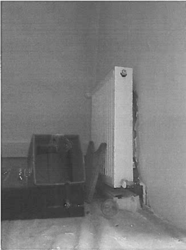
FOTO ZONA INTRARE – finisaje neterminate in spatele radiatorului
