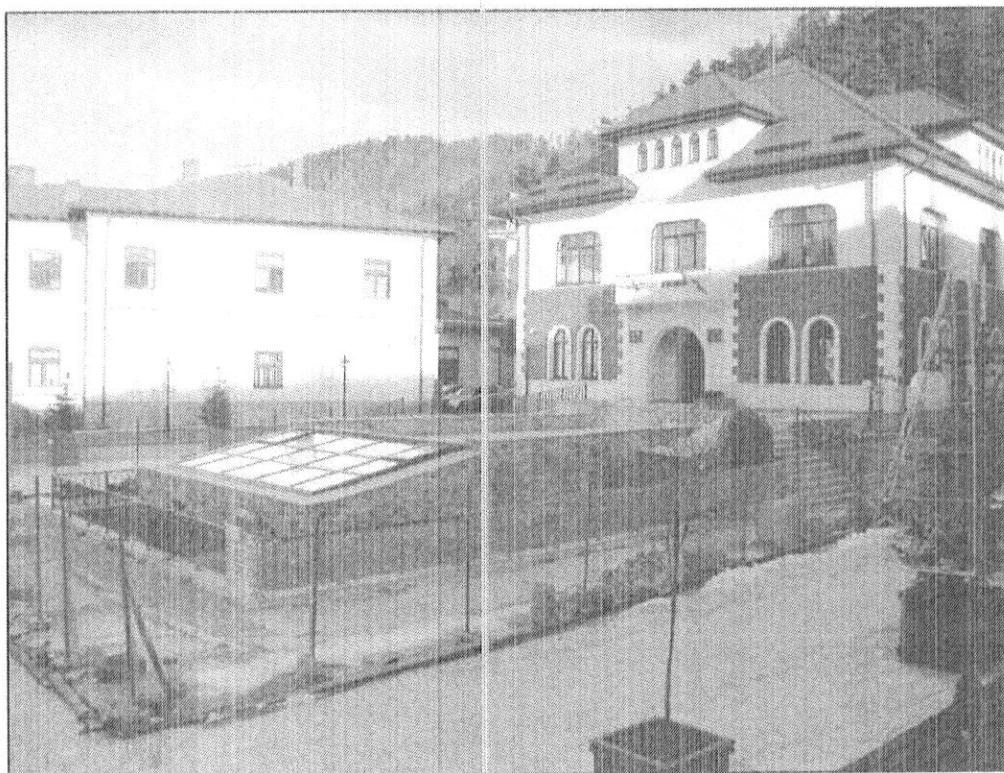
Pl. XXIV. Curtea Domnească – Pivnița II. Vedere exterioară.
