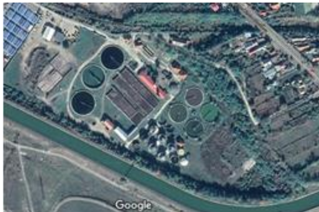
Fig. 4.47. Stația de epurare apă uzată Piatra Neamț
