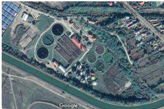
Fig. 4.47. Stația de epurare apă uzată Piatra Neamț
